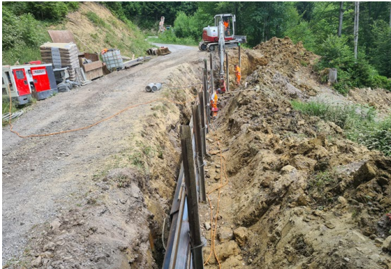
Sanierung Dürrtannstrasse «Ribbertverbauung»
